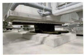
転がり支承(半田市役所)
