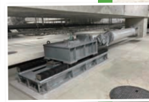
接続型スイッチダンパー (半田市役所)
