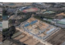
令和5年1月 地盤改良施工
