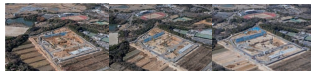
令和4年12月 地盤改良施工
