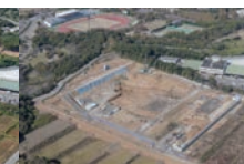
令和4年11月 東側の擁壁を施工
