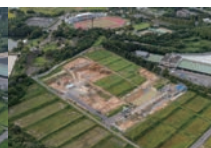
令和4年9月 造成工事施工
