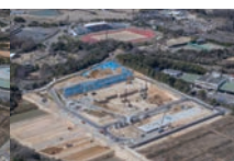
令和5年2月 南側の道路を整備中
