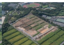
令和4年8月 調整池施工中
