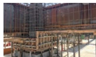
写真3 鉄骨鉄筋コンクリート工事作業状況
