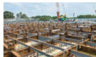
写真2 免震階鉄骨工事状況
