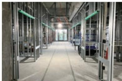
写真3 間仕切り壁施工状況
