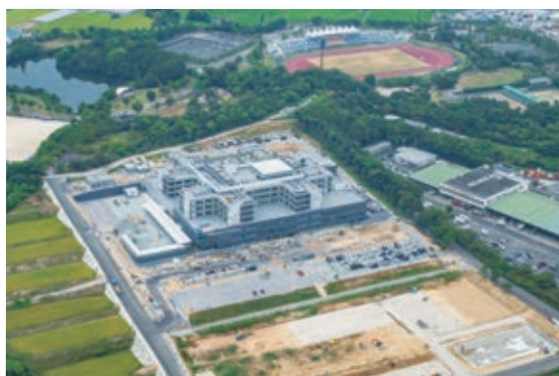
写真1 現場全景写真(令和6年8月19日撮影)
