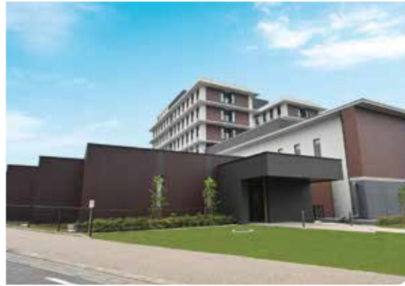
婦人科では、本館と入り口を分けた別棟を設けており、来院しやすい環境を整えました
